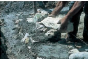
**1. La semelle de fondation est armée de fers droits espacés d'une quinzaine de centimètres et reliés entre eux tous les 50 à 60 cm. Réaliser le ferrailage dans la fouille.**
